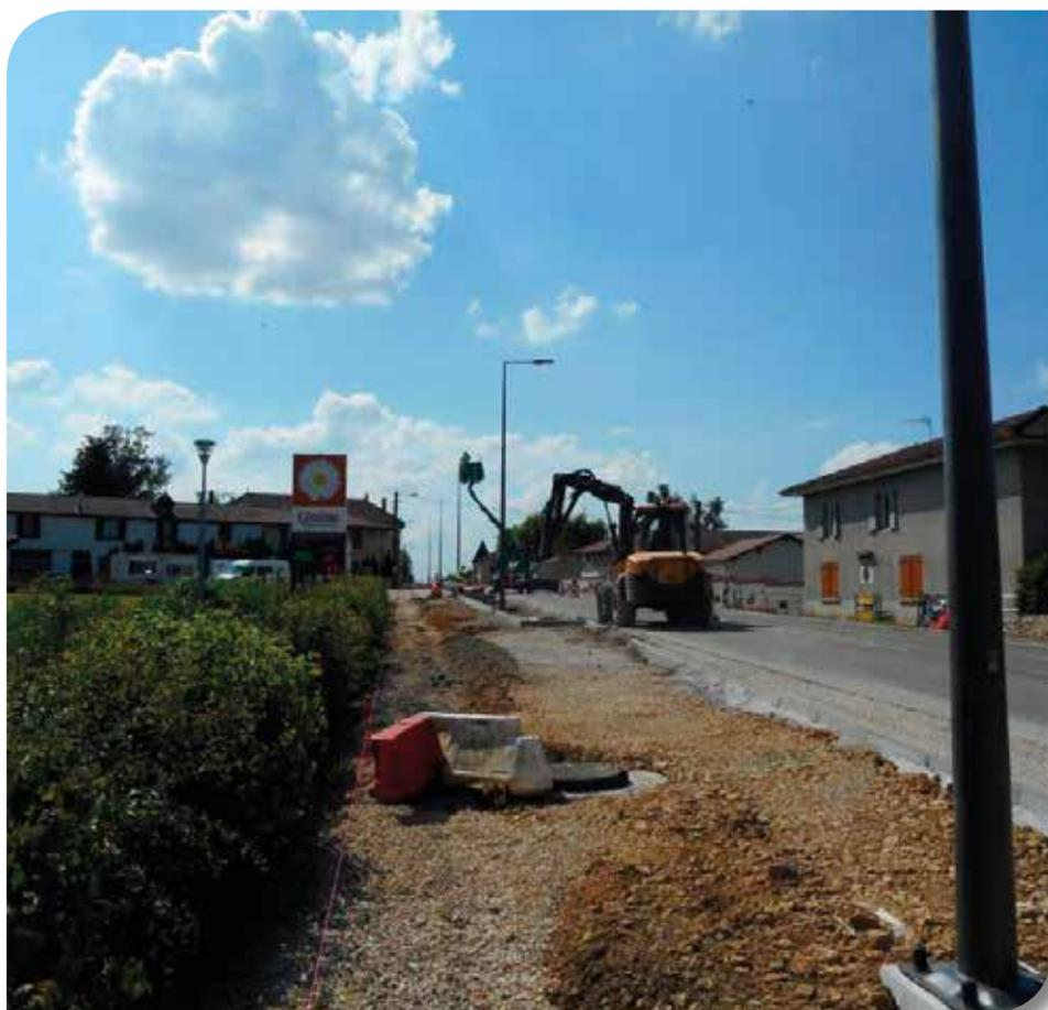
fectués, les réseaux secs (enfouissement électricité, téléphone, fibre et éclairage public) sont en voie d'achèvement. L'ensemble des réseaux seront alors en souterrain et participeront à l'amélioration du cadre de vie.
